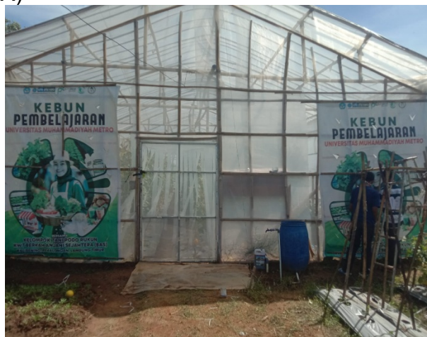
Gambar 1. Green house Tampak Luar Lokasi Desa Kalibening Lampung Timur
